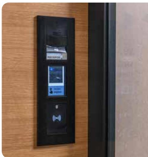
Vstupy do luxusního rezidenčního objektu zabezpečují interkomy **2N® IP Verso**. Díky své modularitě se dá nakonfigurovat přesně podle uživatelských požadavků. Pro Rezidenci Churchill byl zvolen dotykový displej se čtečkou Bluetooth a RFID, která umožňuje využívat mobilní telefon k přístupu do objektu.
