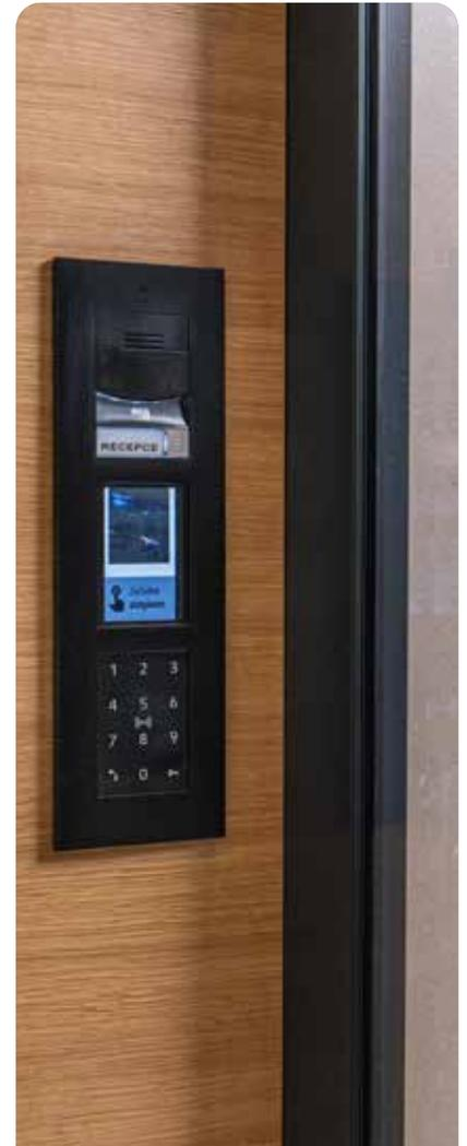
An den Eingängen wurden vier **2N® IP Verso** Sprechanlagen installiert. Unser Partner war besonders von der Modularität des Produkts beeindruckt. In diesem Fall wurde auch der Touchscreen mit einem baumstrukturierten Verzeichnis, einem RFID-Lesegerät und einer Tastatur für den Zutritt gewählt.
